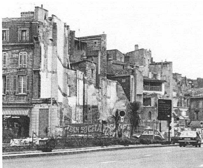
La démolition de la façade Nord de la rue Toulouse-Lautrec pour réaliser un parking souterrain fait apparaître les façades résiduelles des immeubles de la rue Georges-Bonnac.
