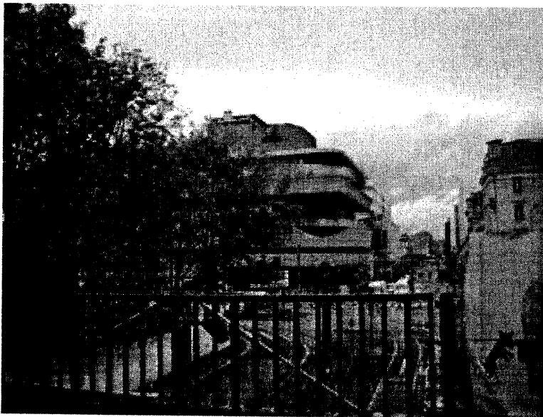
4. L'immeuble de la Caisse d'Epargne et Dépôt, Arch. Edmond Lay
