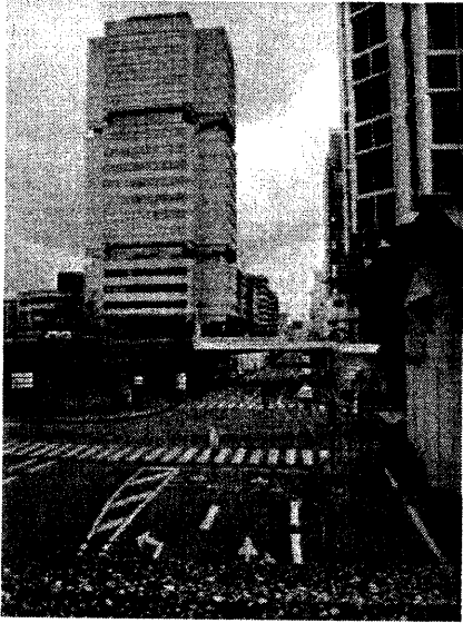
5. L'immeuble de la Communauté Urbaine Bordelaise, récemment réhabilité.
